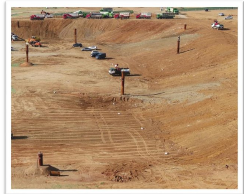
바닥 공사 대체
