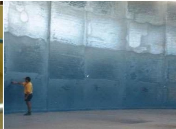
배수탱크 내벽 COATING
