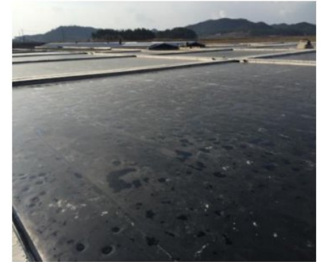
PVC 코팅재 염전 바닥
